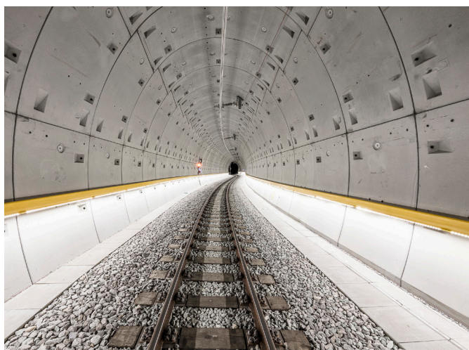
LaneLED GFK, Glatscheras tunnel
